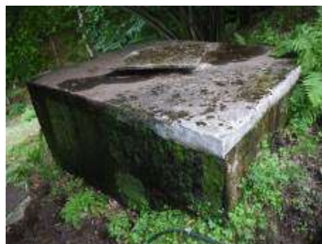
Réservoir de « Malbosc »
