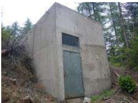
Réservoir de « Camprieu haut »
