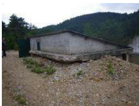
Réservoir de « Villemagne »
