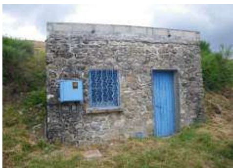
Réservoir du « Devois »
