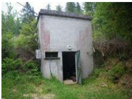
Réservoir de « Camprieu bas »
