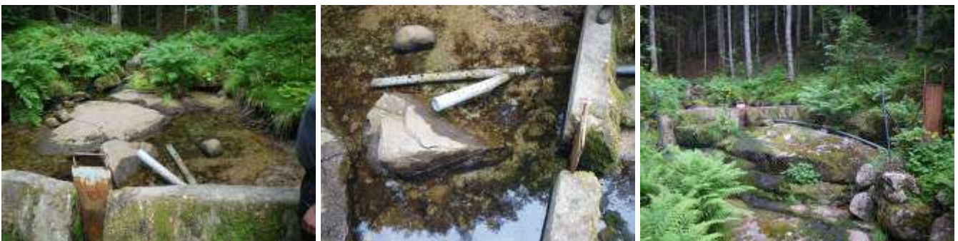
Figure 13 : Vues actuelles du captage des « Tauriers amont » (Source : CEREG Ingénierie)
