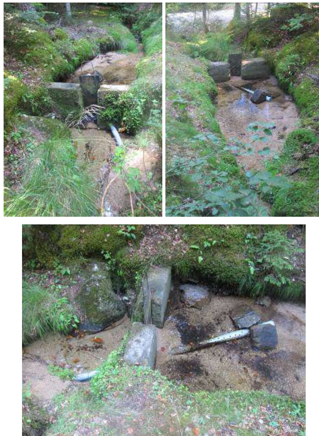
Figure 16 : Vues actuelles du captage de « Balacau » (Source : CEREG Ingénierie)
