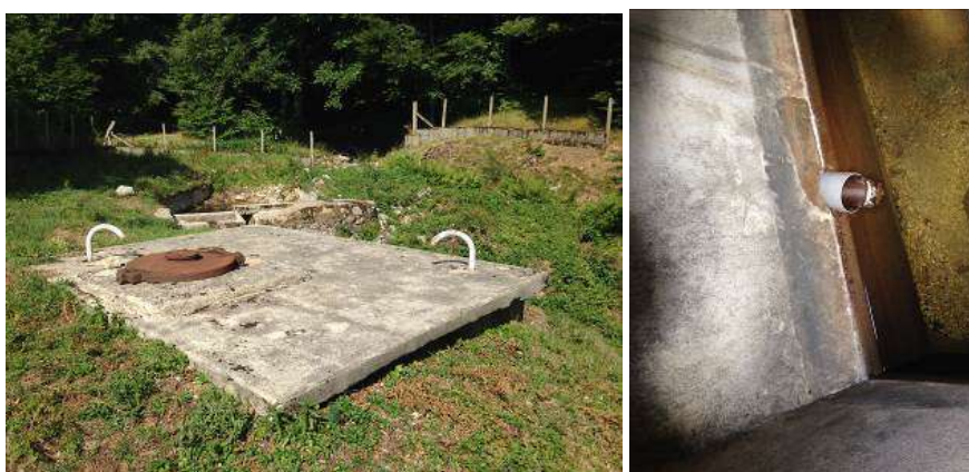
Figure 19 : Vues actuelles de l'ouvrage de décantation du « Devois » (Source : CEREG Ingénierie)
