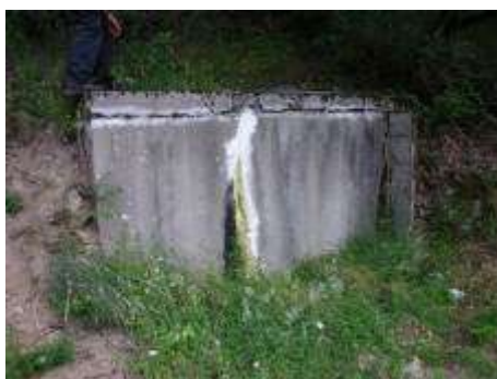
Réservoir de « Ribauriès »
